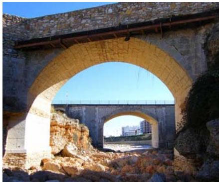
Antiguo y nuevo puente de la carretera Valencia-Barcelona
