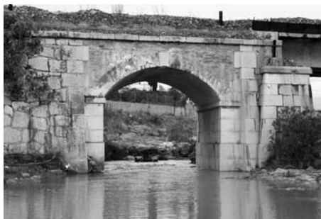
Pont Roig, antiguo puente del ferrocarril de Vinaròs, 1866-1867.
