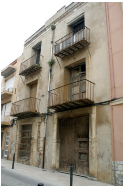
Estat actual en 1998 de les dues naus que es conserven
