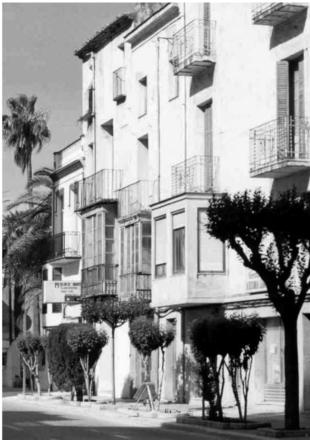
Casa de la familia Vizcarro en la calle San Francisco. Actualmente en este solar está la calle Franciscanos.
