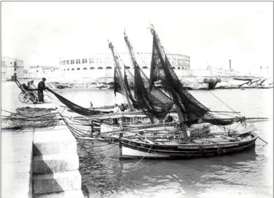
Muelle de poniente, conocido como contramoll, cuya construcción fue solicitada por J. Rafels (Foto Roisin/IEFC, col. J. Simó)
