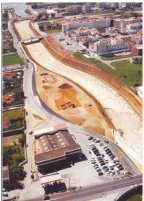
*Obres de canalització del tram final del riu Cervol.
